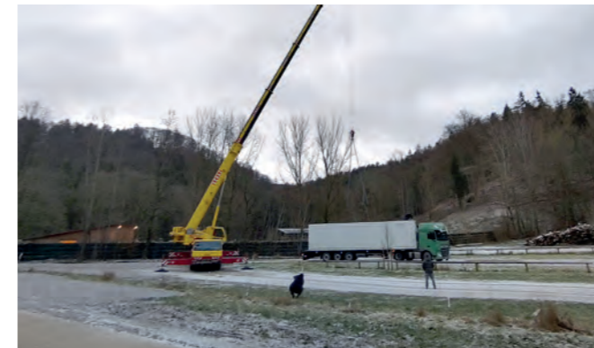
Anlieferung des Containers in Hundshaupten, der bei eisigen Temperaturen über Bäume, einen Bach und die Mauer an seinen Standort gehoben wurde.
